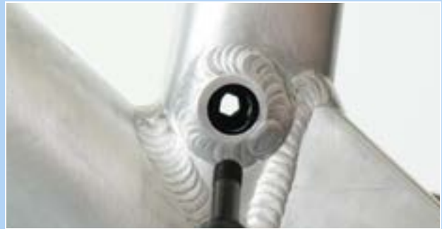
Rysunek 205: Otwór w miejscu styku sworznia
